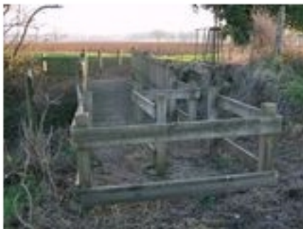
Franchissement de pelle en chicane
